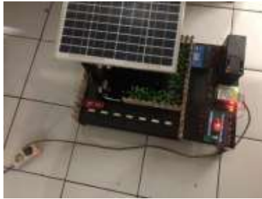
Gambar 26. Kondisi ketika Automatic Transfer Switch menyala
