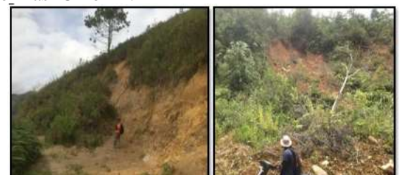
Gambar 26. Foto kenampakan gerakan tanah jenis debris slide AN – 46 dijumpai di Jalan Talang Sariak dan AN – 49 di Jalan Damasraya
