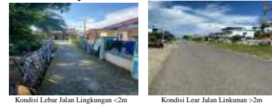
Gambar 7 Kondisi Lebar Jalan Lingkungan
