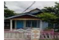
Kondisi Bangunan Tertata
