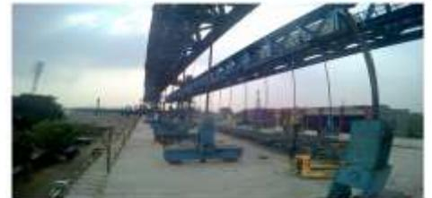
Gambar 16. PT bar dan *Steel Shoe* setelah dilepas
