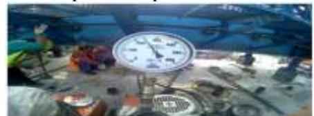
Gambar 18. Pengukuran Tegangan *Stressing*
