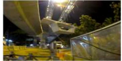
Gambar 12. Penempatan *Box girder*
